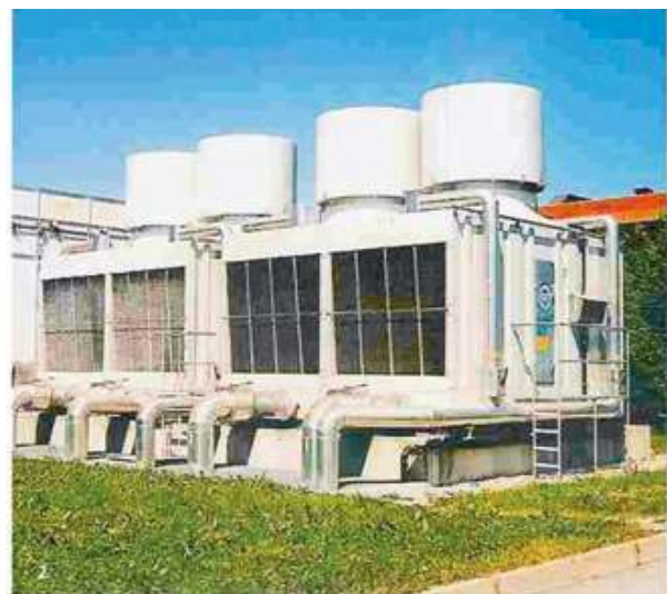
Bild III-28: Saugbelüfteter Verdunstungskühlturm für offenen Kreislauf mit Axialventilator mit Kreuzstrom Luft/Wasserführung (KTK Kühlturm Karlsruhe GmbH)
